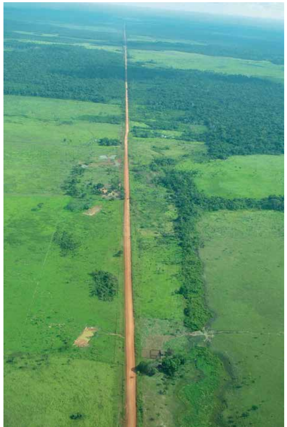
Vista aérea del tramo caminero Riberalta - Guayaramerín, actualmente asfaltada, Beni | Fotografía: Juan Carlos Montero
