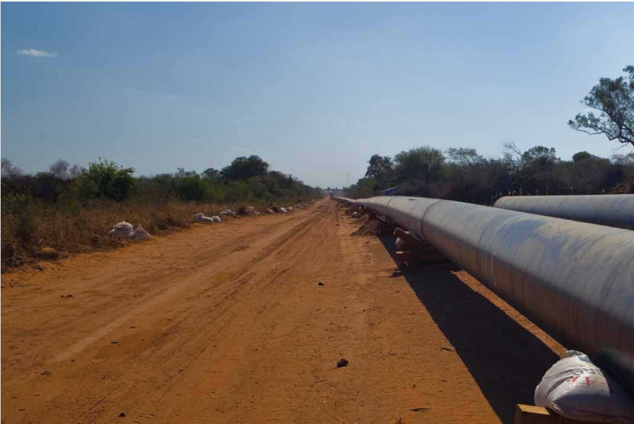
Gasoducto Bolivia - Brasil, nuevo cruce de Río Grande | Fotografía: Walter Ridder
