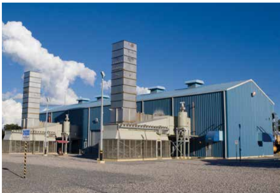
Planta de compresión de gas, estación Izozog | Fotografía: Walter Ridder
